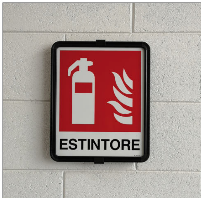
INSTALLAZIONE DI SEGNALI MONOFACCIALI
